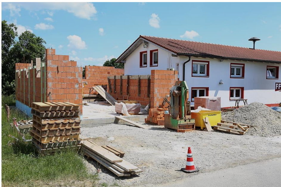
Inzwischen ist der Bau vorangeschritten – Stand 11. Juni
